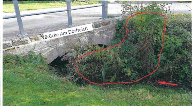
Foto 18: Zustand des Vieselbach oberhalb der Brücke Am Dorfteich Foto 19: abflussbehindernder Bewuchs vor der Brücke Am Dorfteich
