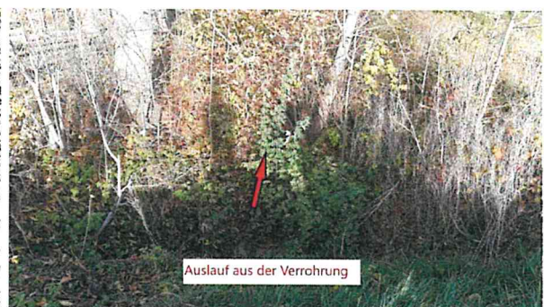
Foto 15: Blick vom Auslaufbauwerk in Fließrichtung
