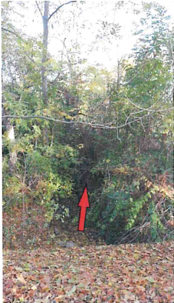
Foto 28: Abflussprofil unterhalb der Brücke Erfurter Straße
