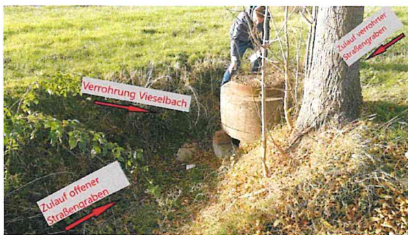
Foto 11: Schachtbauwerk vor der Erfurter Straße
