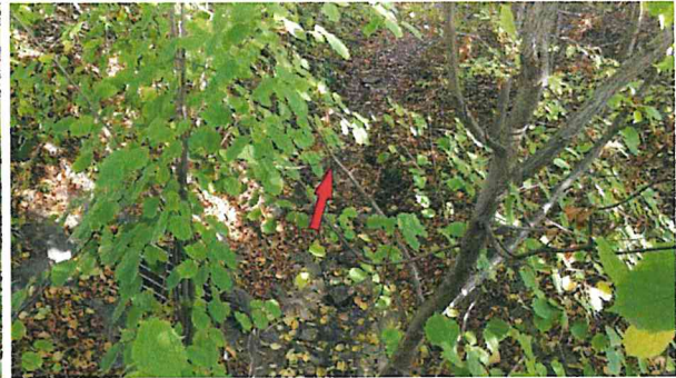
Foto 245: tiefes Abflussprofil unterhalb der Fußgängerbrücke
