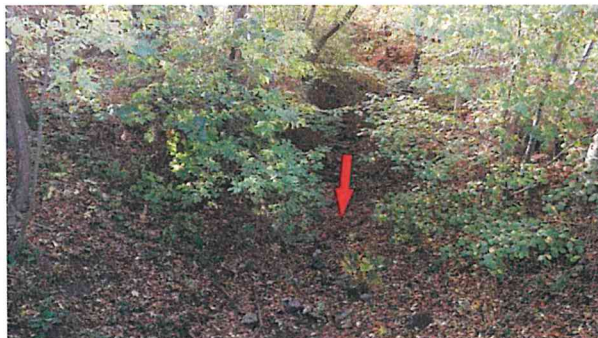
Foto 26: Abflussprofil oberhalb der Brücke Erfurter Straße im Ortskern
