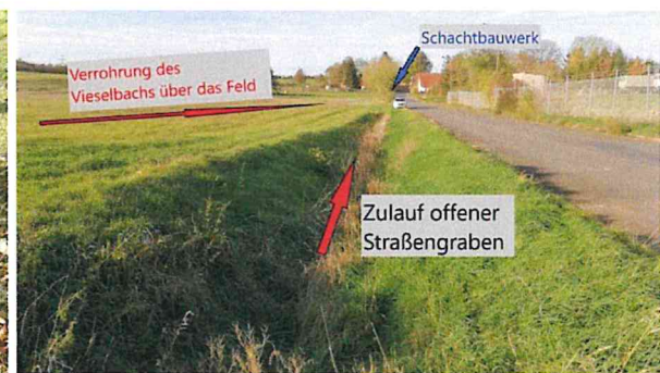
Foto 12: Verrohrung Vieselbach mit rechtsseitigem Zulauf Straßengraben
