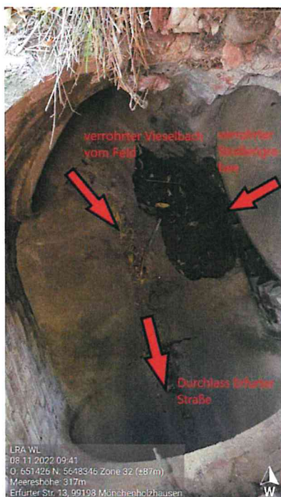
Foto 13: Blick in den geöffneten Schacht
