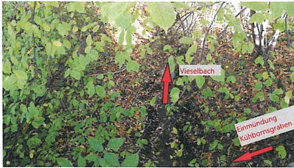
Foto 30: Vieselbach unterhalb der Brücke An der alten Ziegelei im Einmündungsbereich des Kühbornsgrabens
