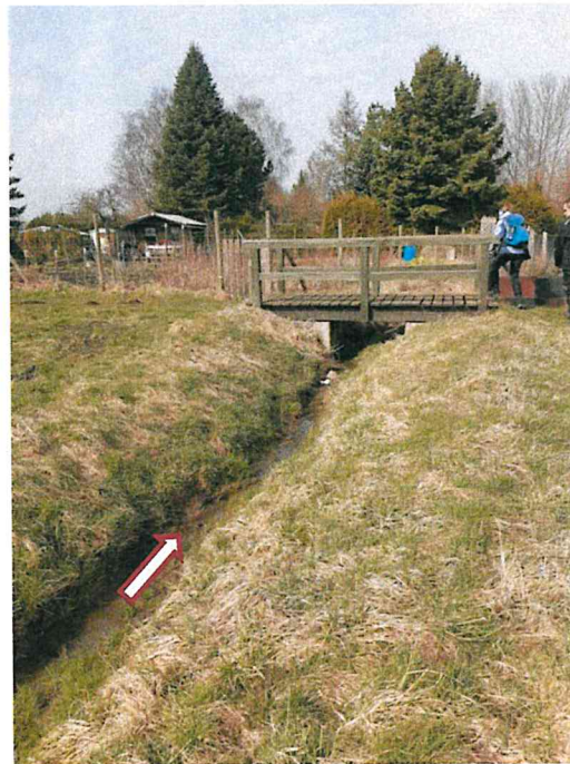
Abbildung 24: Brücke vor Kleingartenanlage
