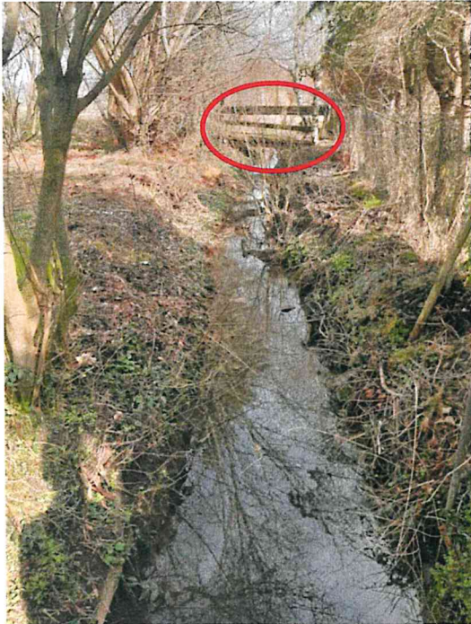
Abbildung 29: Überprüfung der Standsicherheit Zufahrt
