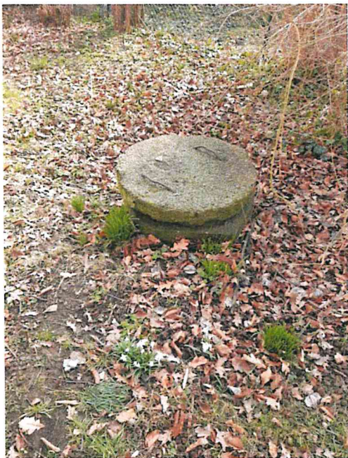
Abbildung 14: vermutlicher Schacht der Gewässerverrohrung
