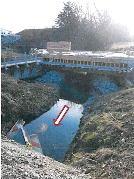
Abbildung 65: Brückenneubau "Am Niedertor"
