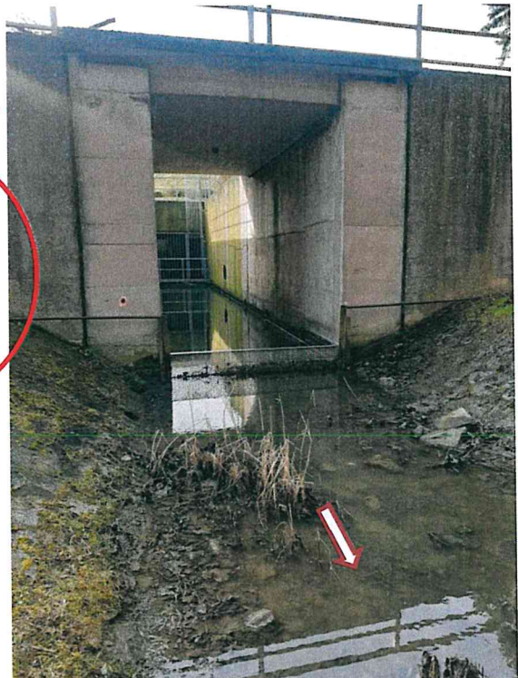
Abbildung 39: Grundablass, Durchlass
