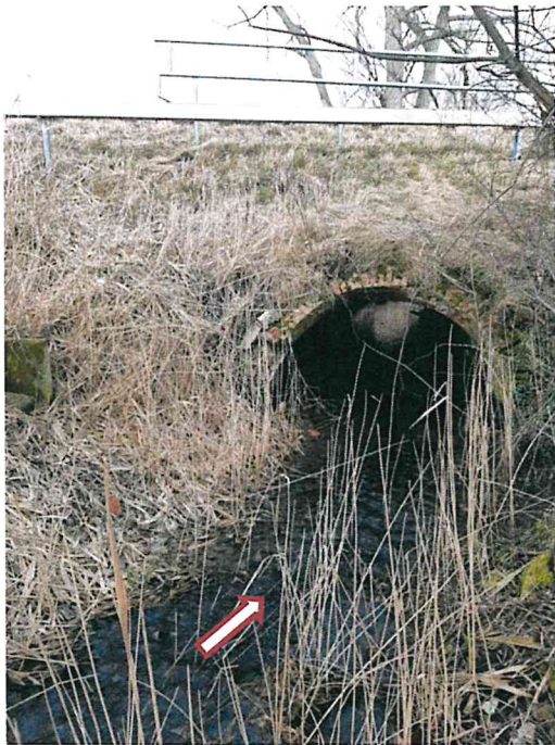
Abbildung 45: Durchlass Bahn, Oberstrom
