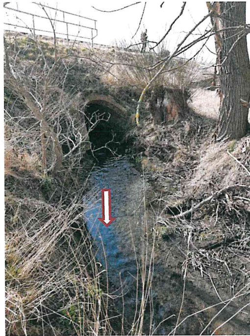
Abbildung 46: Durchlass Bahn , Unterstrom
