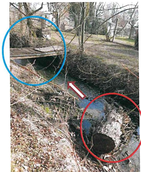
Abbildung 55: instabiler Steg, Schwemmgut
