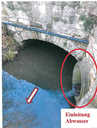
Abbildung 64: Friedhofsbrücke von Unterstrom aus
