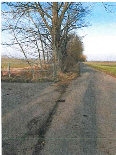
Abbildung 67: asphaltierter Weg Richtung Andisleben und Gebesee
