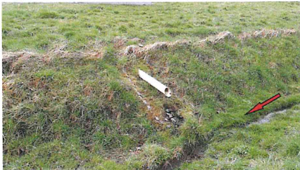
Foto 10 Einkürzung des Auslaufrohres durch den Entwässerungsbetrieb
