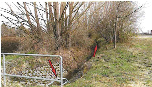
Foto 24 Auslaufgitter Durchlass Weg
