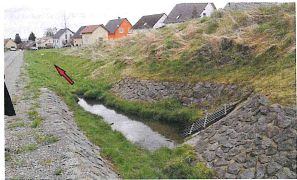
Foto 9 Beräumung von Ablagerungen aus der Sohle
