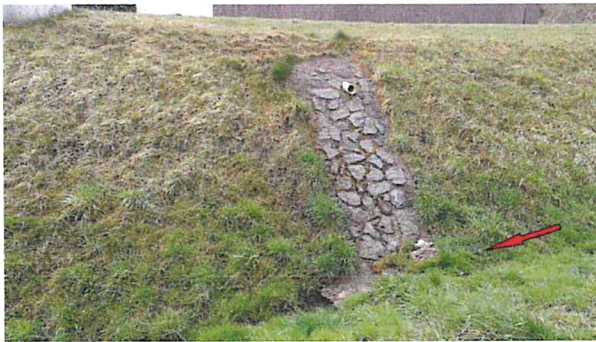
Foto 8 Sicherung der Ausspülungen in der Sohle
