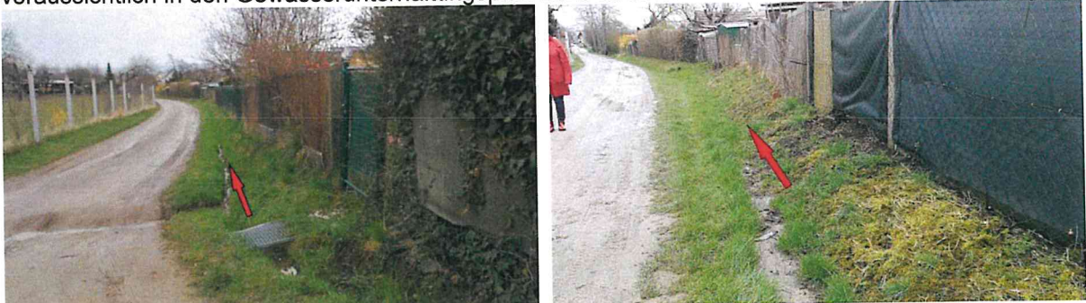
Foto 4 und 5 Wiederherstellung des Grabenprofils erforderlich
