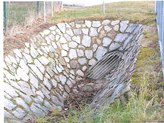
Foto 20 aus dem Jahr 2008 Einlauf mit Gitter
