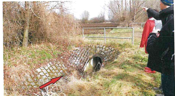
Foto 23 Einlaufgitter Durchlass Weg
