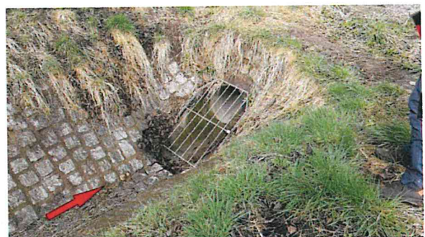
Foto 25 Einlaufgitter 2. Bahnquerung
