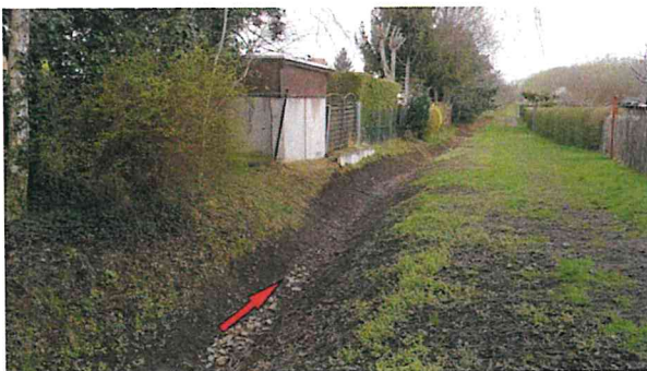
Foto 32 und 33 beräumtes Abflussprofil- Rasenansaat erforderlich
