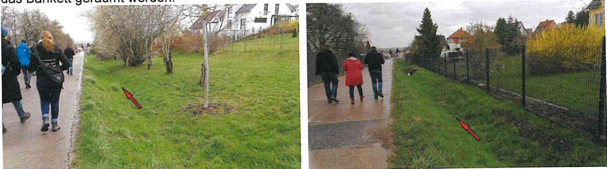
Foto 6 und 7 Profilierung des Abflussprofils durch GUV und Beäumung des Banketts durch das TVA
