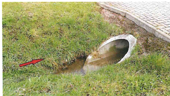
Foto 17 und 18 Sicherung des Durchlasses erforderlich
