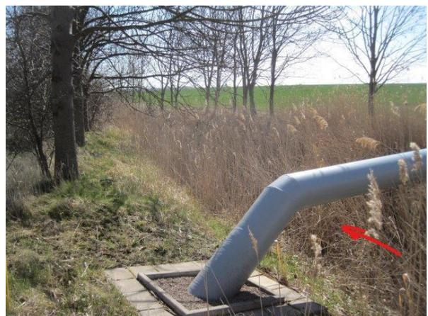
Im Bereich bis zur Gasleitungsquerung existiert Schilfbestand nur auf den Böschungen. Dieser Schilfbestand muss auch hier abschnittsweise gemäht und beseitigt werden. Teilweise stehen Büsche sehr tief im Abflussprofil, hier ist ein Schnitt auf Stock erforderlich. Diese Maßnahmen müssen in den Basisplan im PROGEMIS eingetragen werden.
