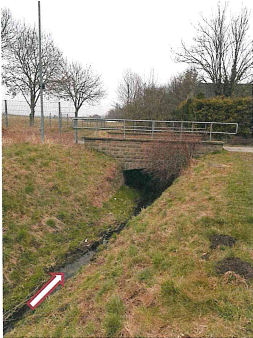
Abbildung 24: Straßenbrücke, Blick von Oberstrom
