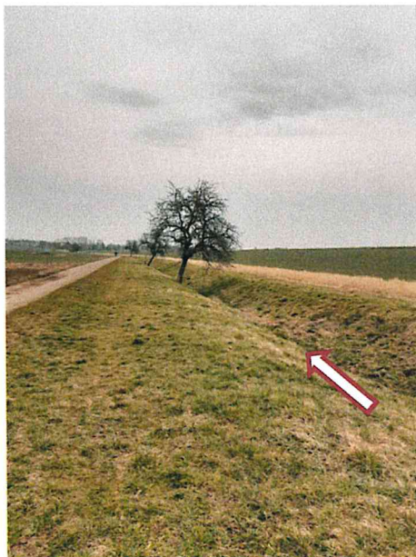
Abbildung 17: Blick in Fließrichtung entlang des Radweges
