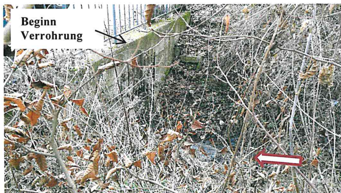
Abbildung 22: Einlaufbereich Verrohrung, Rechen
