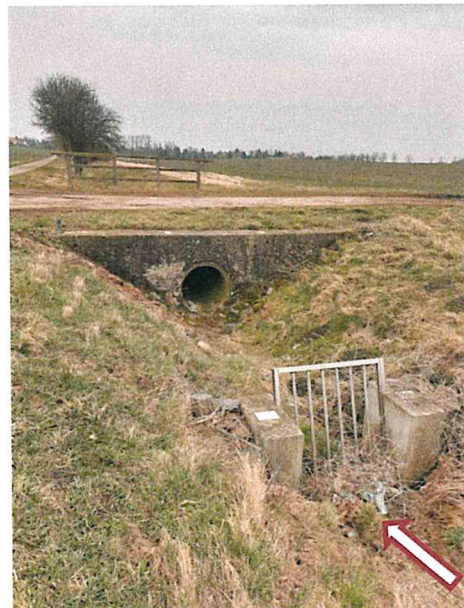
Abbildung 18: Rechen – lose Befestigung
