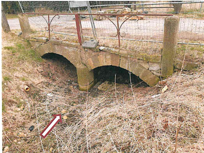
Abbildung 10: (private) Brücke 50 m im Unterstrom
