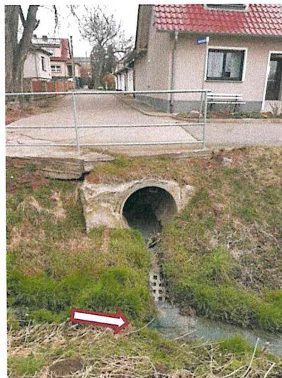
Abbildung 3: Einleitung Abwasser
