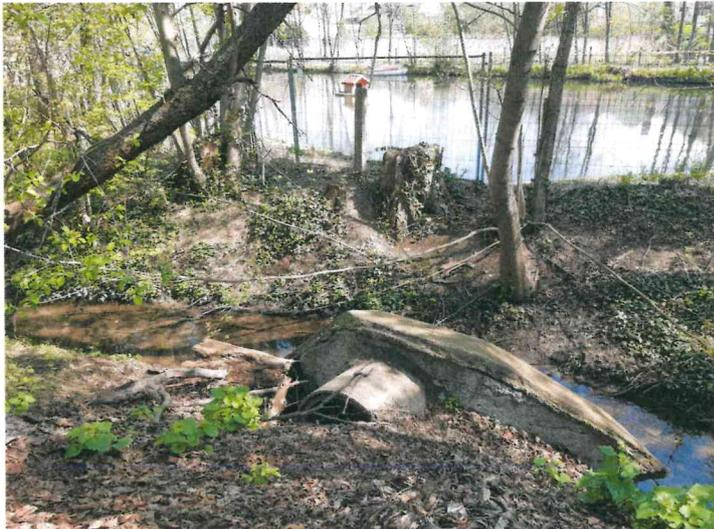
Abbildung 36: ausgebrochenes Einlaufbauwerk
