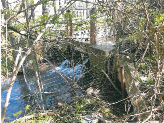
Abbildung 35: Stauvorrichtung mit Dammbalkenverschluss
