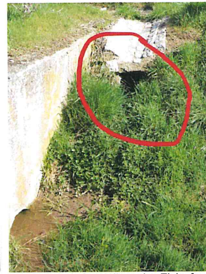
Foto 10 Wiederherstellung des Einlaufs
