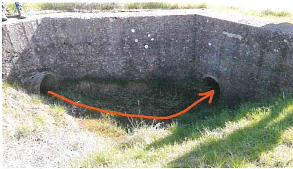
Foto 7 Änderung der Fließrichtung von Norden in Richtung Osten
