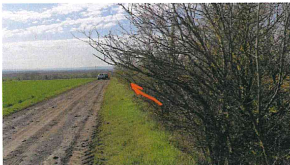
Foto 3 und 4 starker Bewuchs im Grabenprofil bis in den Verkehrsraum des Feldweges hinein
