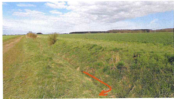
Foto 21 Windgraben knickt nach Süden ab
