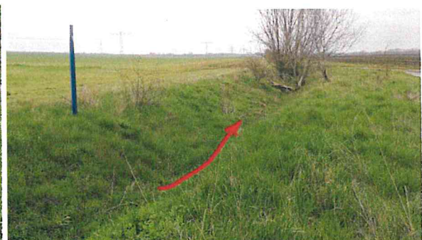
Foto 24 ordnungsgemäßes Gewässerprofil am Ende von Abschnitt 3
