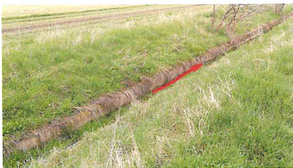
Foto 25 und 26 Sohlverbau mit Beton-U-Profilen
