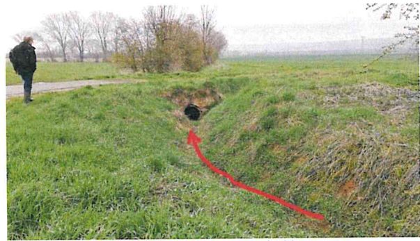
Foto 7 Durchlass am Ende des 1. Abschnitts
