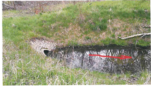
Foto 16 Ende des Grundablasses und Beginn Grabenprofil
