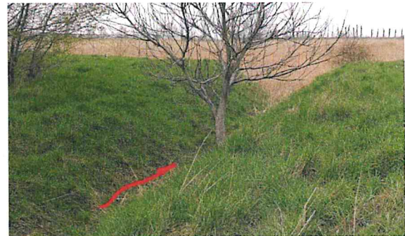
Foto 12 ordnungsgemäßer Zustand im Bereich der Mündung in den Speicher Döllstädt
