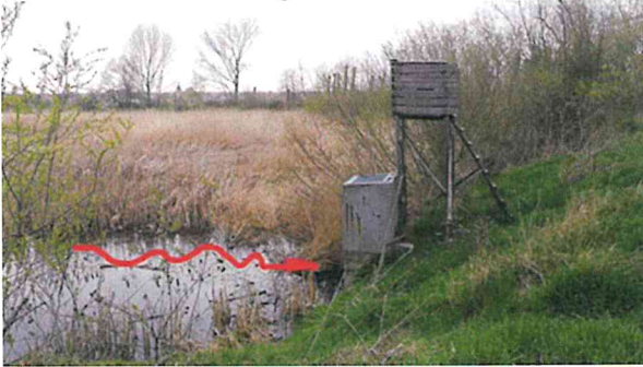
Foto 15 Mönchbauwerk mit Grundablass im Auslaufbereich des Speichers
