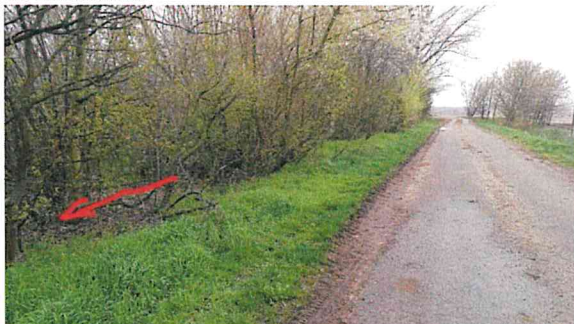
Foto 1 kein Abflussprofil erkennbar
