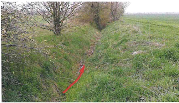
Foto 8 und 9 ordnungsgemäßes Abflussprofil
