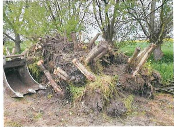
Foto 54: aus dem Abflussprofil entfernte Wurzelstöcke
