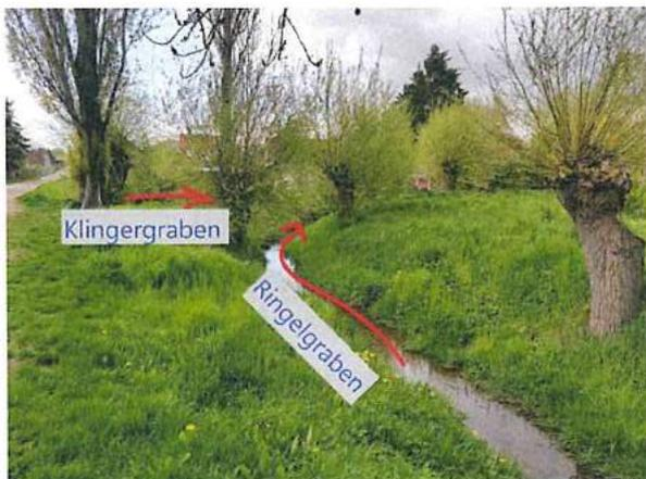
Foto 112: ausreichendes Abflussprofil vor dem Zusammenfluss mit dem Klingergraben
