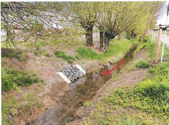
Foto 109: Auslaufbauwerk Klärgrube
