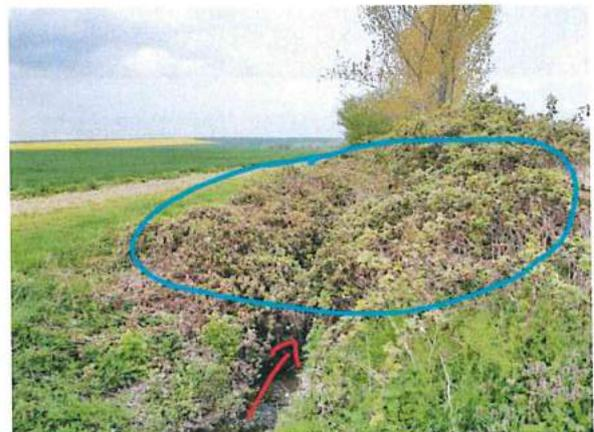
Foto 43 und 44: das Abflussprofil einengende Brombeerhecke
