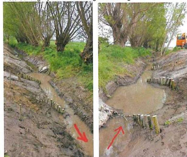
Foto 58 und 59: Lenkung des Stromstrichs durch Einbau von Weidenbuhnen
