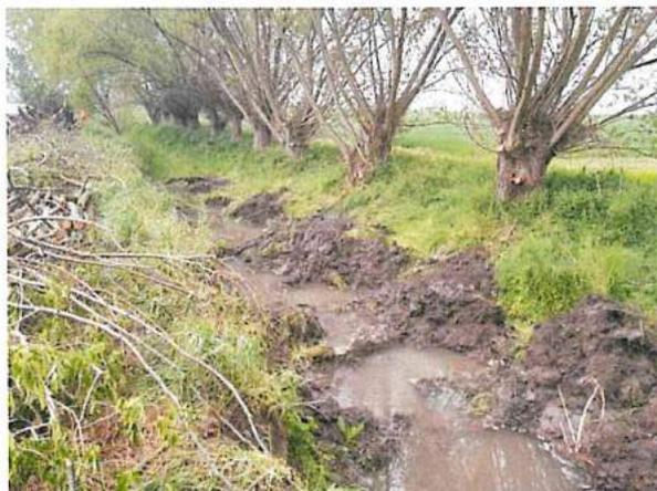
Foto 55: Abflussprofil nach der Entnahme der Wurzeln
