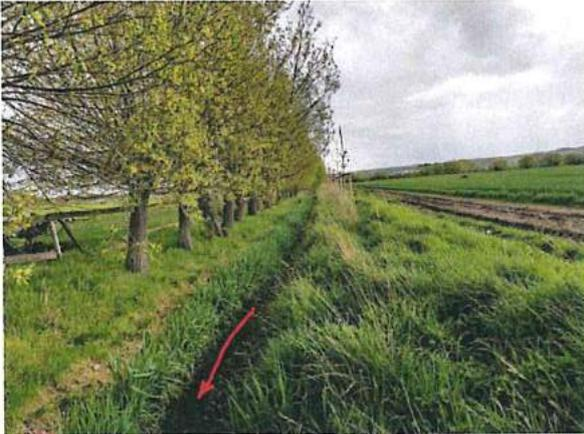
Foto 95: für den Wasserabfluss ausreichendes Abflussprofil
