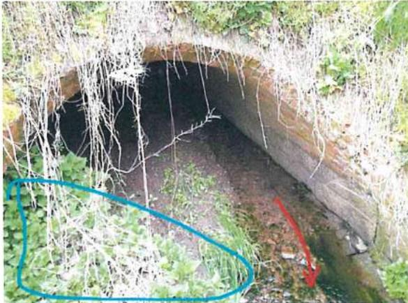
Foto 35: Anlandungen im Anschluss an den Bahndurchlass
