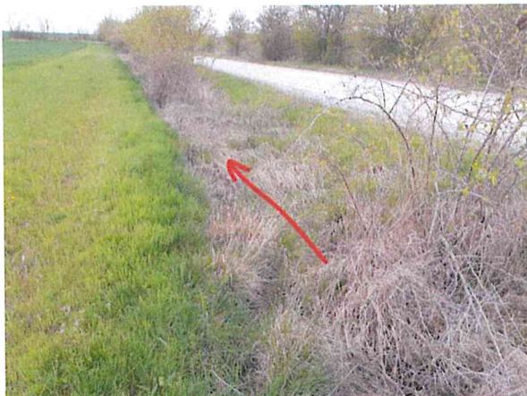
Foto 39 und 40: ausreichendes Abflussprofil bis zum Einlauf in die Verrohrung
