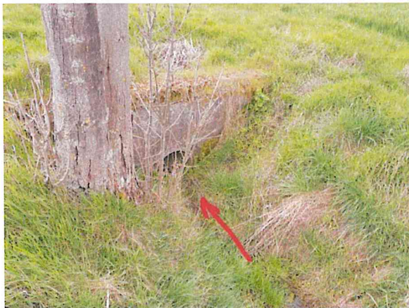
Foto 17: Wegedurchlass vor Einmündung des Graben überm Hauptgraben in den Hauptgraben
