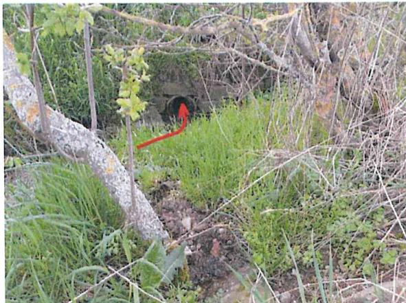
Foto 41: Einlauf in die Verrohrung
