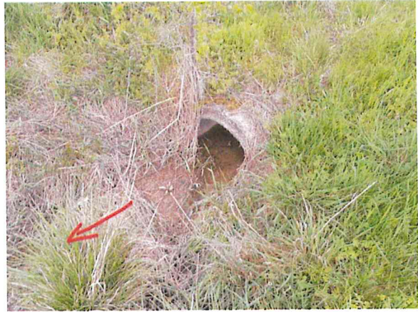
Foto 37 und 38: Zustand des Abflussprofils unmittelbar ober- und unterhalb des Wegedurchlasses
