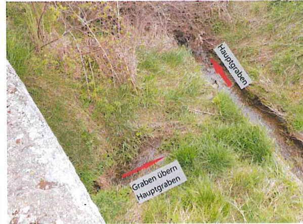
Foto 18: Einlauf des Graben überm Hauptgraben in den Hauptgraben
