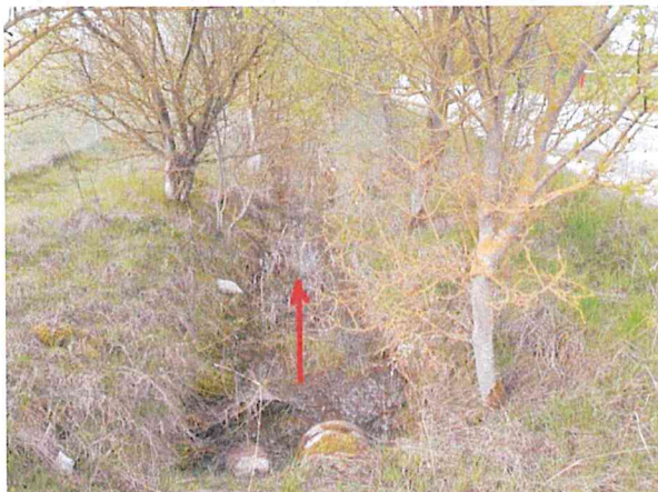
Foto 30: Abflussprofil unterhalb der Einmündung des Grabens Abfindung
