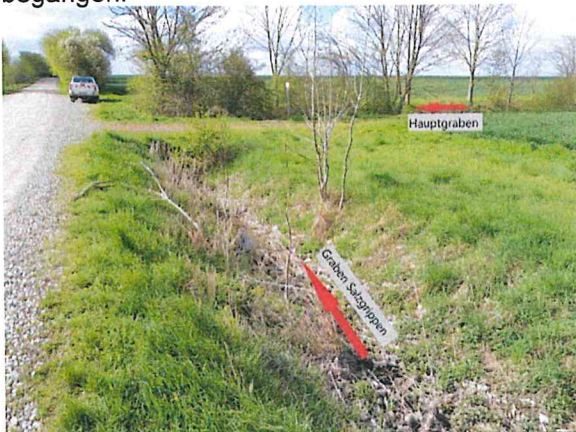
Foto 19: Graben Salzgrippen im Bereich der Einmündung in den Hauptgraben
