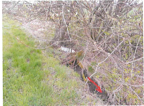
Foto 5: Abflussprofil oberhalb der Einmündung in den Hauptgraben
