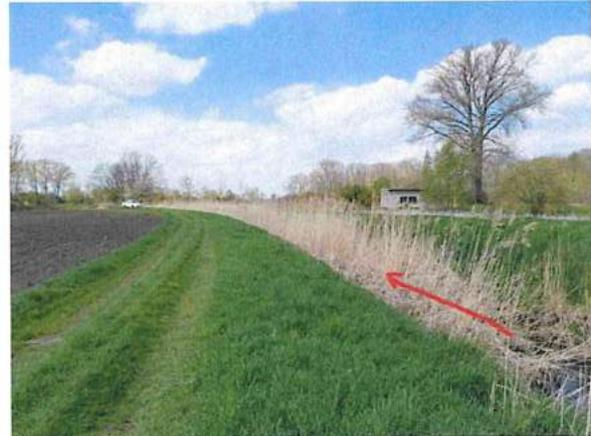
Foto 66: Schilfbewuchs im Abflussprofil
