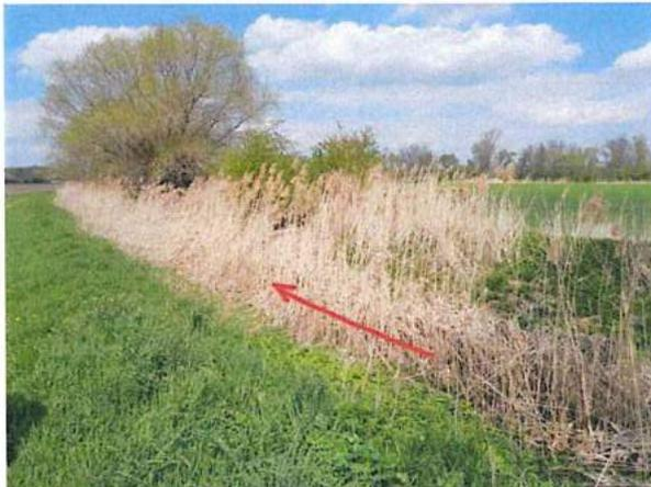
Foto 59: Schilfbewuchs im Abflussprofil
