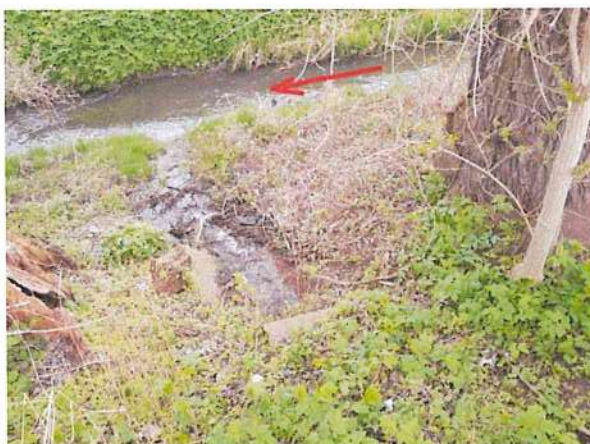
Foto 81: Drainageeinleitung auf der linken Böschung
