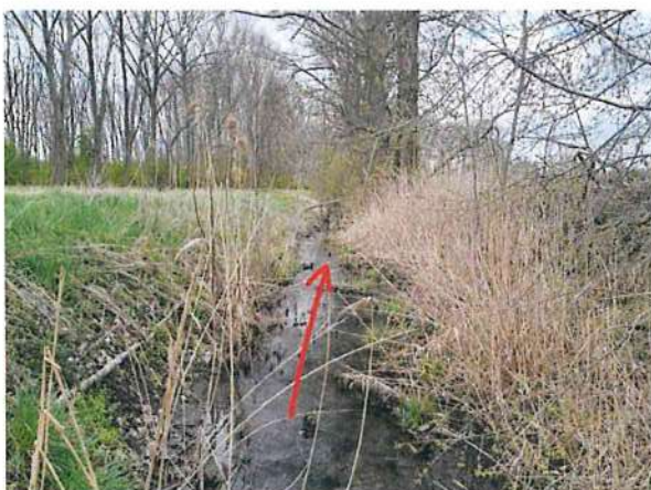
Foto 36: Abflussprofil unterhalb der Brücke Berlstedter Straße
