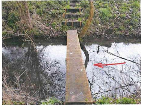
Foto 27: ungesicherter Steg
