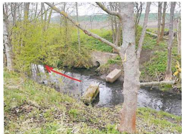
Foto 78: ehemalige Stauvorrichtung und rechtsseitige Einmündung eines Grabens von untergeordneter wasserwirtschaftlicher Bedeutung
