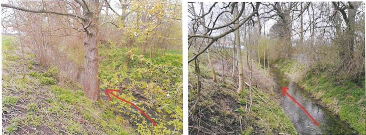
Foto 64 und 65: für den Wasserabfluss ausreichendes Abflussprofil
