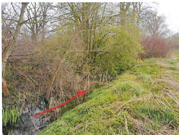
Foto 23: Bruchholz im Abflussprofil
