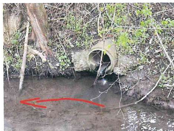
Foto 33 und 34: Abwassereinleitungen in die Vippach
