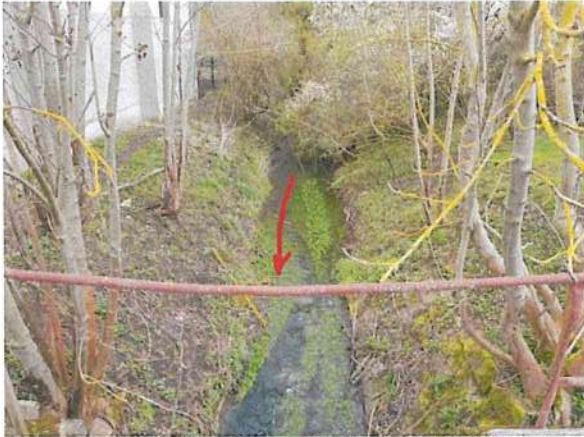
Foto 66: Bewuchs im Abflussprofil oberhalb der Mühlstraße
