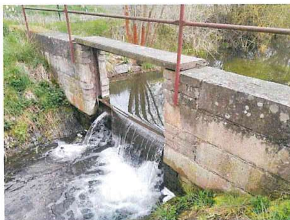
Foto 57: Wehranlage ca. 350 m unterhalb der Brücke "Am Stausee"
