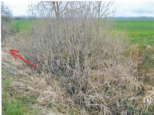
Foto 11 und 12: abflussbehindernde Sträucher im Abflussprofil
