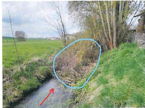
Foto 54: Rosenbusch im Abflussprofil
