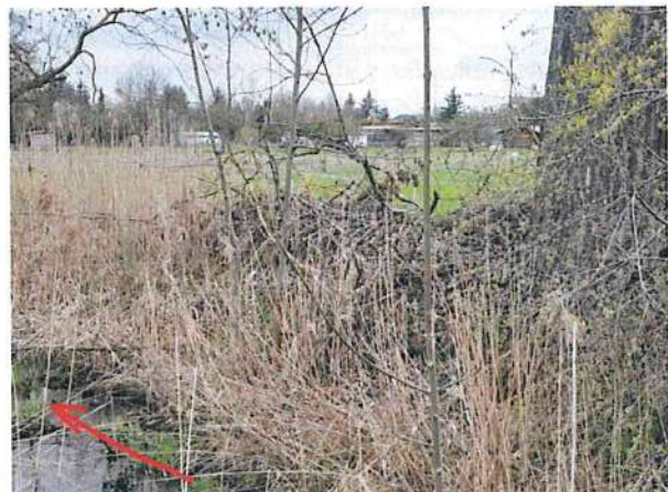
Foto 37: Ablagerung von Bruchholz auf der rechten Böschung
