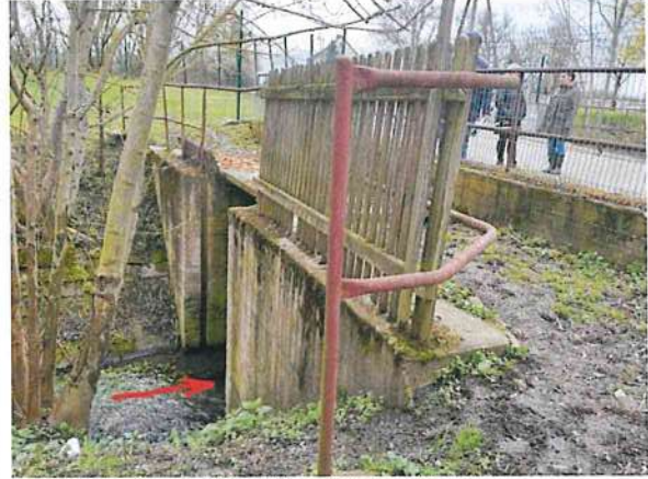
Foto 67: Brücke Mühlstraße möglicher Staustelle
