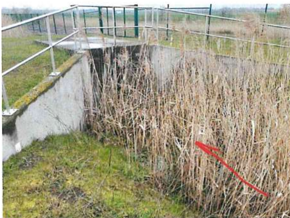
Foto 3 und 4: Vippach im Bereich Zufahrt RRB ICE-Trasse
