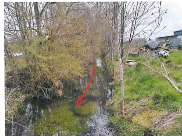
Foto 58: angestaute Vippach oberhalb der Wehranlage
