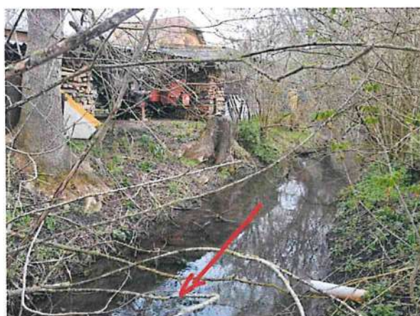
Foto 31 und 32: ins Abflussprofil hineinragende Entwässerungsröhre
