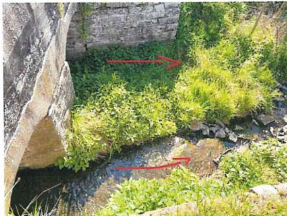
Foto 21: Auslaufbereich der Straßenbrücke
