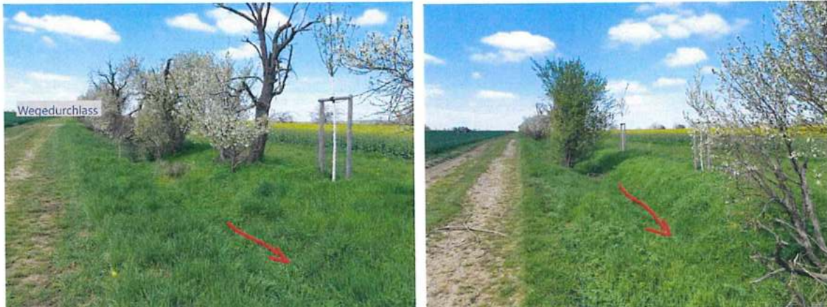
Foto 55 und 56: für den Wasserabfluss ausreichendes Abflussprofil unterhalb des Durchlasses 1
