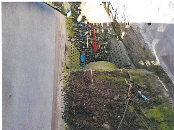
Foto 6: Einlauf in die Verrohrung im Bereich "Im Tor"
