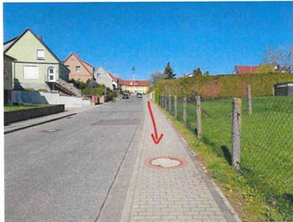
Foto 10: verrohrter Verlauf des Weißbach
