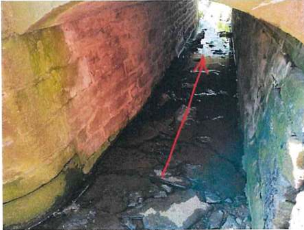
Foto 19: rechte Röhre der Straßenbrücke
