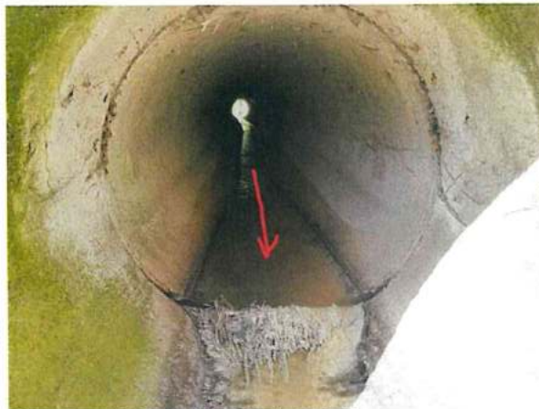
Foto 68 und 69: Durchlass 4 der L 1044
