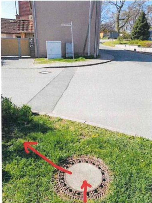
Foto 9: Schacht 1m Tor/Töttelstädter Straße
