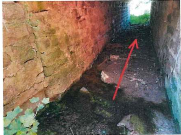
Foto 20: linke Röhre Straßenbrücke
