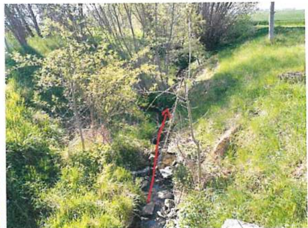
Foto 22: Gewässerprofil unterhalb der Straßenbrücke
