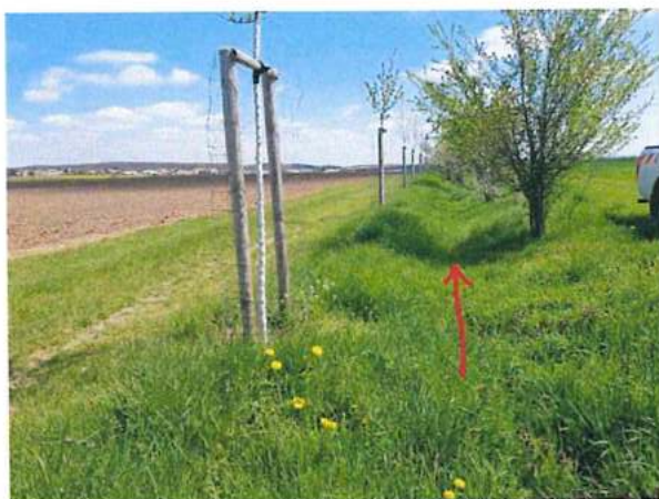
Foto 45 und 46: Beginn des Kuppelsborns- für den Wasserabfluss ausreichendes Abflussprofil
