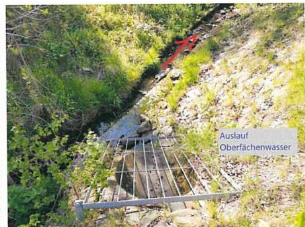
Foto 24: Auslaufbauwerk Oberflächenwasser
