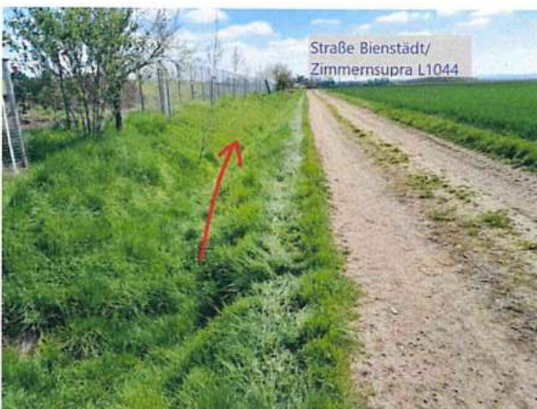
Foto 64: ausreichendes Abflussprofil entlang des Geländes der agrar Bienstädt GmbH
