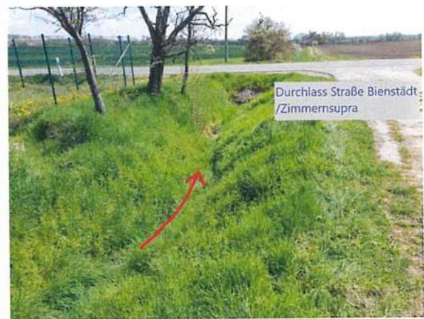
Foto 67: Abflussprofil vor Durchlass 4 der L 1044
