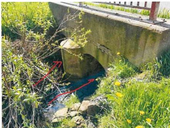
Foto 18: Einlaufbereich Straßenbrücke Bienstädt/Töttelstädt
