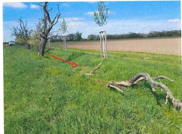
Foto 45 und 46: Beginn des Kuppelsborns- für den Wasserabfluss ausreichendes Abflussprofil
