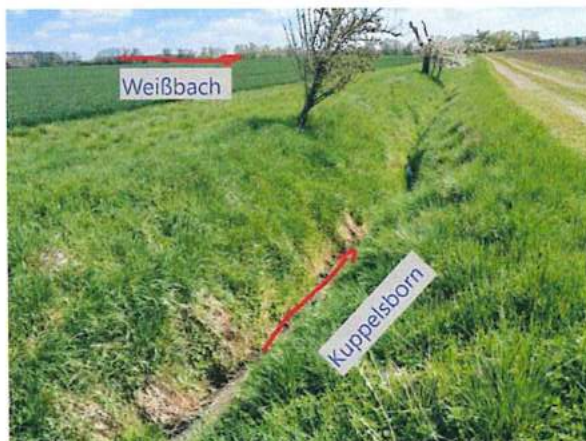
Foto 70 und 71: für den Wasserabfluss ausreichendes Abflussprofil
