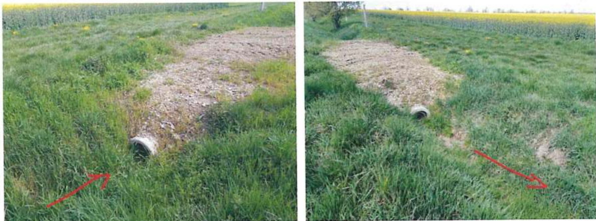
Foto 57 und 58: Ein- und Auslaufbereich des Durchlasses 2
