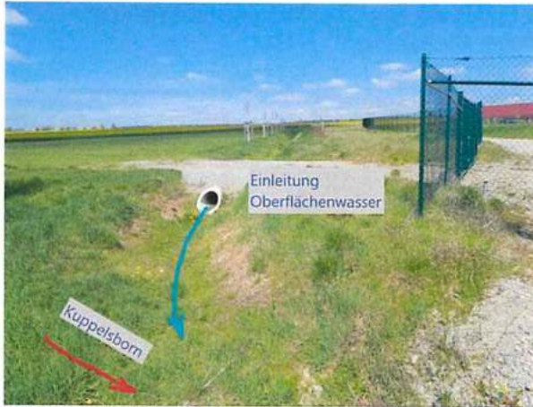
Foto 60 und 61: Einleitung von Oberflächenwasser oberhalb des Durchlasses 3
